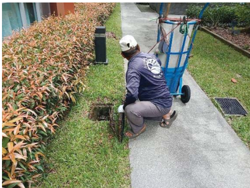
ตรวจสอบท่อระบายน้ำและขุดลอกตะกอนดิน
