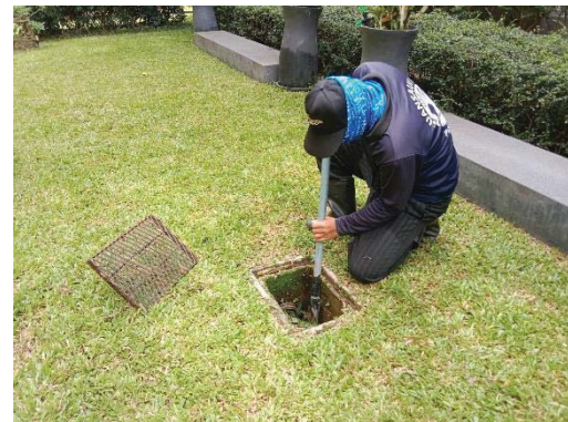
ตรวจสอบท่อระบายน้ำและขุดลอกตะกอนดิน
